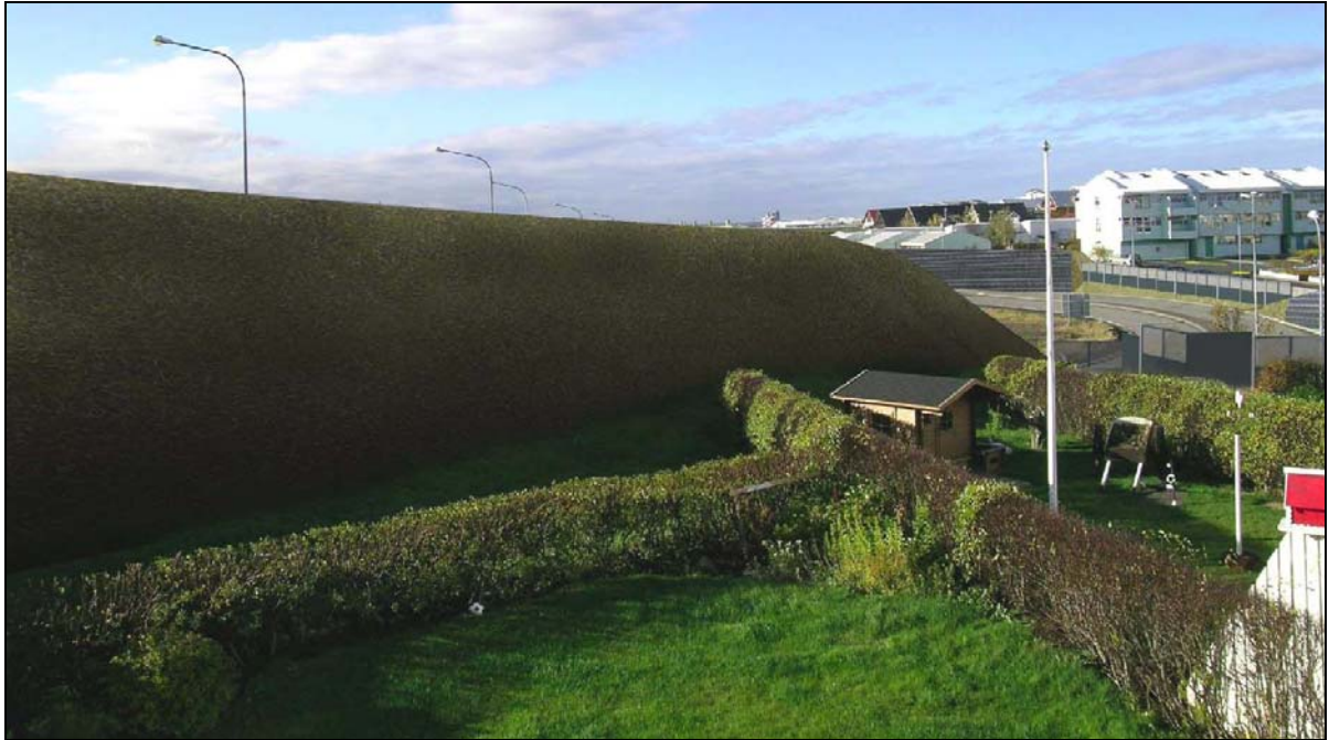
Mynd 5.20 Mynd tekin við Suðurhvam 22 og sýnir kost 2 , það er 4 m háa gabíon hljóðmön. Ekki er hægt að lækka Reykjanesbraut á þessum stað (ljósmynd: Mannvit 2006).
