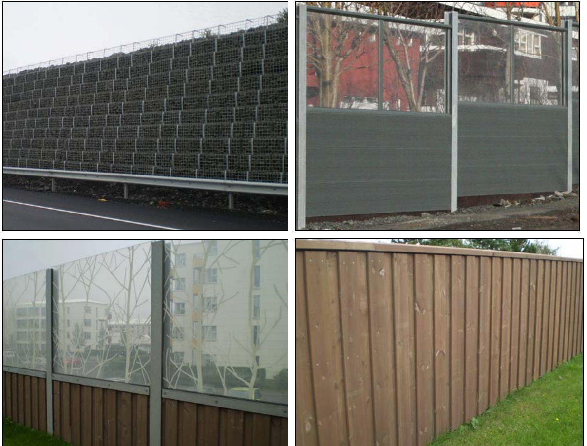
Mynd 5.5 Gabíon hljóðmön (efst til vinstri). Dæmi um útlit hljóðveggja, úr gleri og áli (efst til hægri), úr gleri og timbri (neðst til vinstri), úr timbri (neðst til hægri) (ljósm.: Mannvit hf., 2007).
