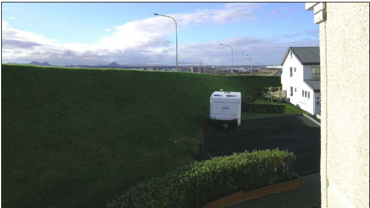
Mynd 5.15 Mynd tekin við Suðurhvamm 25, og sýnir núverandi hljóðmön, um 2 m háa yfir vegi, meðfram Reykjanesbraut (ljósmynd: Mannvit 2006).
