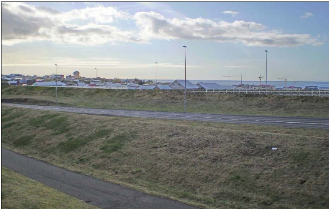
Mynd 5.25 Mynd tekin við Blikaás 13 og sýnir kost 1 , það er um 2 m háa hefðbundna hljóðmön við lækkaða Reykjanesbraut (ljósmynd: Mannvit 2007).
