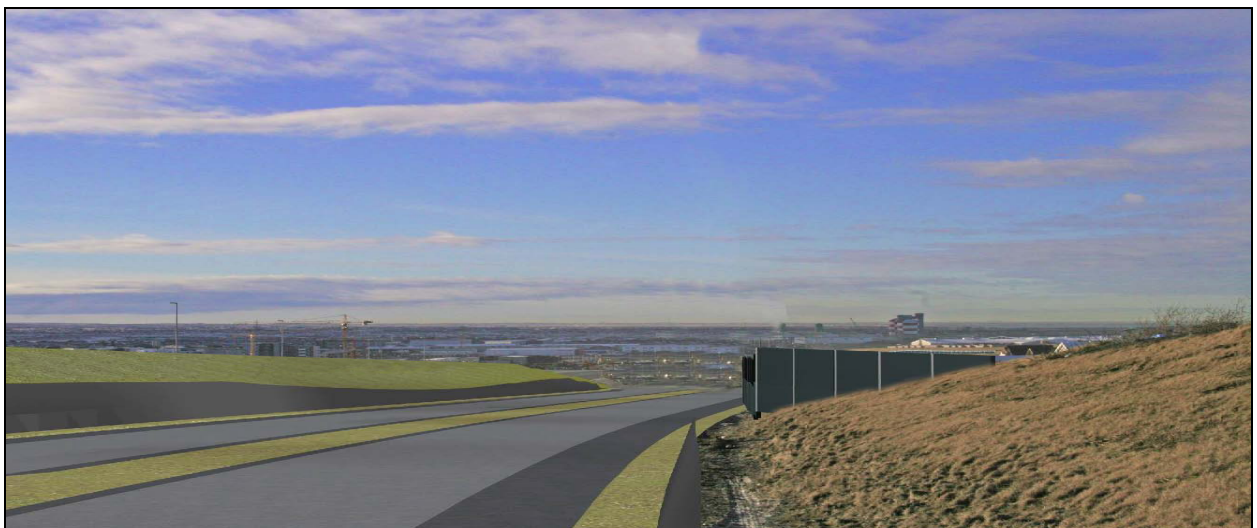
Mynd 2.8. Mynd tekin á móts við Háahvamm/Ásbraut austan við vegamótin við Strandgötu. Fyrirhuguð breyting á Reykjanesbraut, kostur 1 , sett inn á myndina. Á þessum stað lækkar Reykjanesbrautin á um 600 m kafla. Hægra megin verður byggð 2 m gabíon hljóðmön í stað veggjar, sjá einnig mynd 5.5 .
