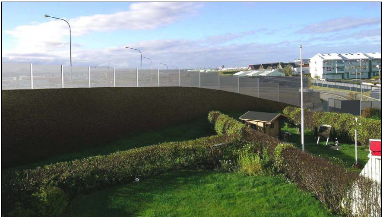
Mynd 5.21 Mynd tekin við Suðurhvam 22 og sýnir kost 1 , það er 2 m háan hljóðvegg úr gleri ofan á nýrri 2 m gabíon hljóðmön. Ekki er hægt að lækka Reykjanesbraut á þessum stað (ljósmynd: Mannvit 2006).
