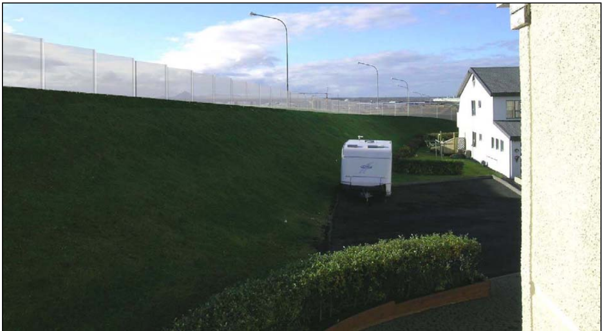
Mynd 5.17 Mynd tekin við Suðurhvamm 25 og sýnir kost 1 , það er 2 m háan hljóðvegg úr gleri ofan á nýrri 2 m gabíon hljóðmön. Ekki er mögulegt að lækka Reykjanesbrautina á þessum stað (ljósmynd: Mannvit 2006).
