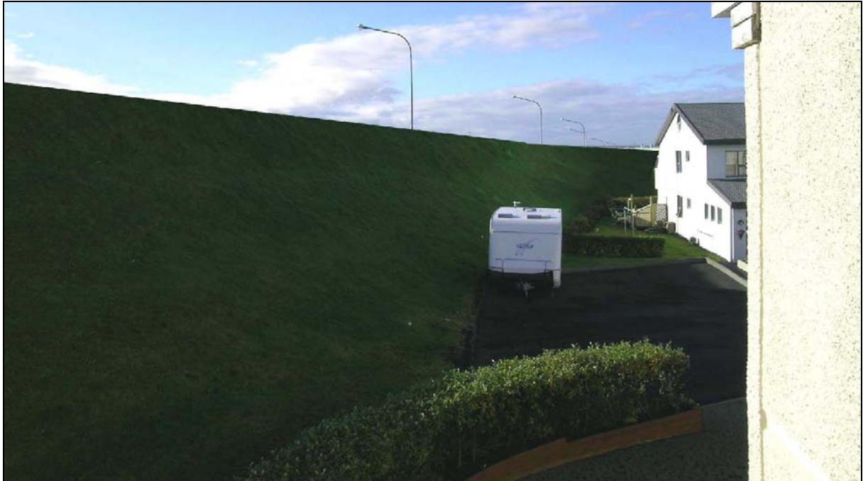
Mynd 5.16 Mynd tekin við Suðurhvamm 25 og sýnir kost 2 , það er um 4 m háa gabíon hljóðmön. Ekki er mögulegt að lækka Reykjanesbraut á þessum stað (ljósmynd: Mannvit 2006).
